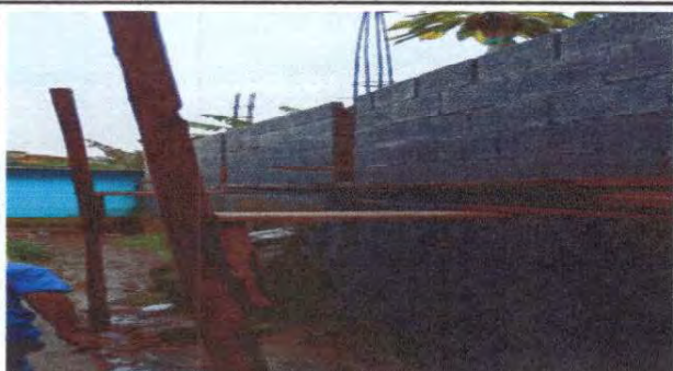
Foto 1: Reparación de muro de contención
