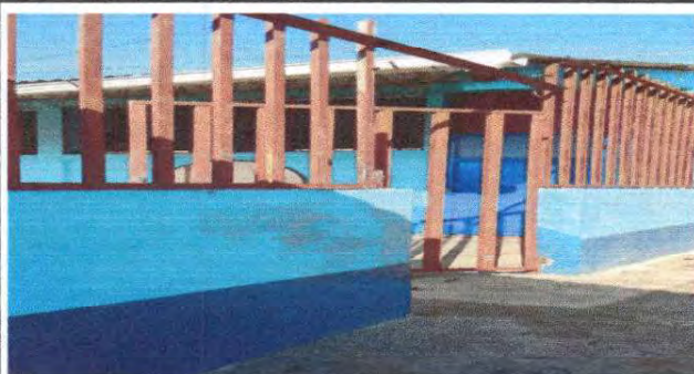
Foto 11: Pintura en muros exteriores e interiores
