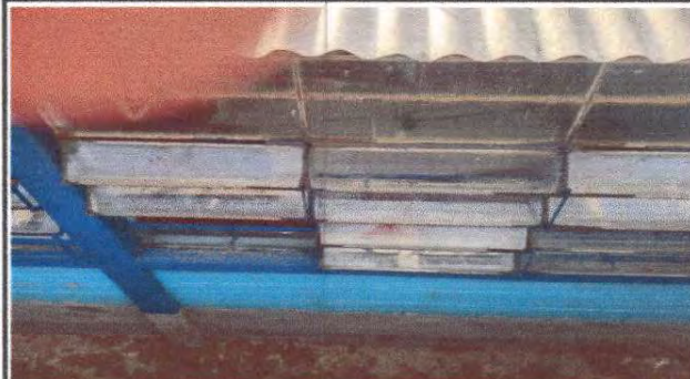
Foto 10: Sustrucción de balcones de metal Mantenimiento de Estructura de metal de Ventanas de vidrio
