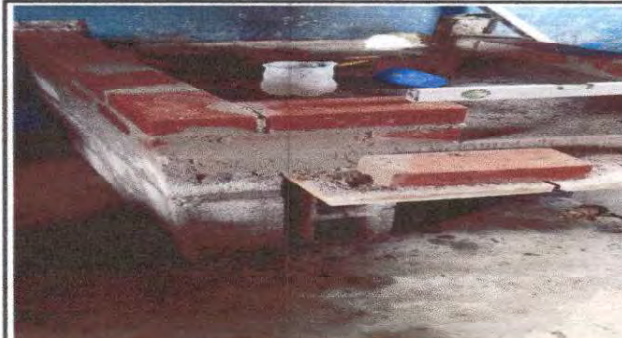
Foto 12: Sustrucción de estufa rural (completa) incluye chimenea y plancha de metal
