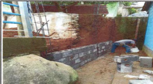
Foto 2: Reparación de muro perimetral de block
