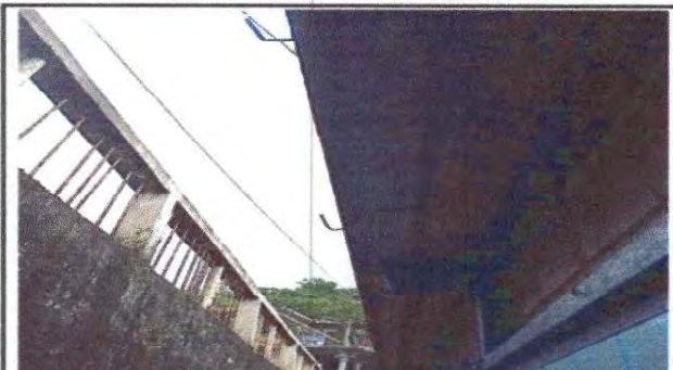
Foto 4: Sustitución de canal de pvc
