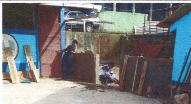
Foto 9: Mantenimiento PORTON (lijado, cambio de tubo, sujeciones, aplicación de pintura)
