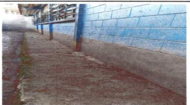
Foto 3: Repello en muro
